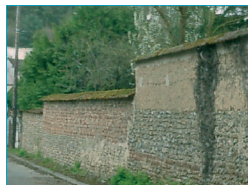
Les hauts murs de clôture maçonnés referment l'espace rue.
