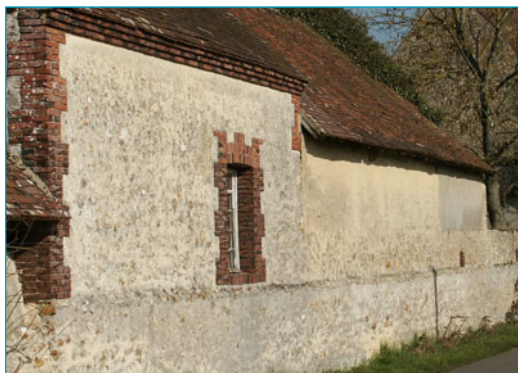
Enduit à pierre vue au premier plan de la construction, et enduit couvrant au second plan. Saint-Ange et Torçay.
