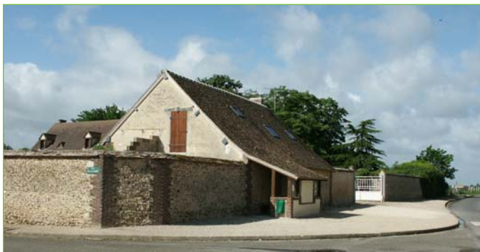
A gauche, en 2007, la façade sur rue de l'ancienne grange transformée en gîte.
