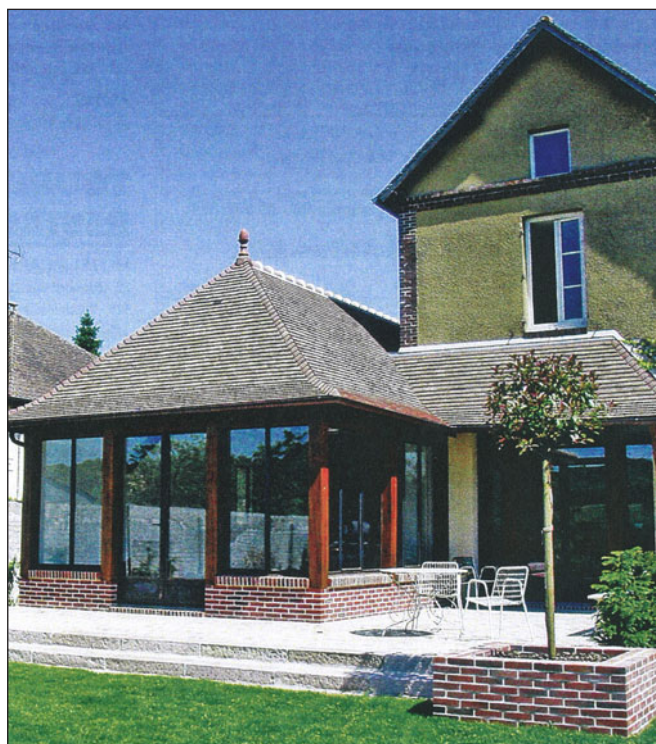
Véranda aux seuls murs vitrés, projet de Michel JUBERT, architecte DPLG.
