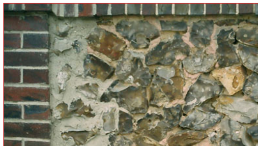
Maçonnerie de brique et silex.
