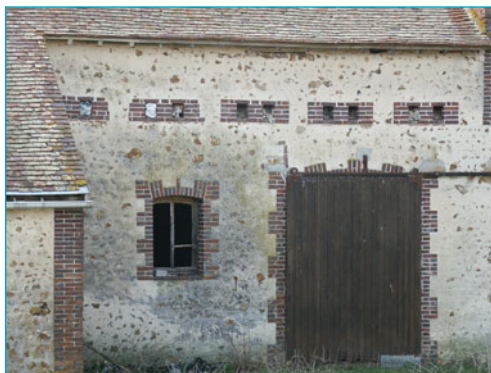
Rognons de silex enduits à pierre vue. Saint-Ange et Torçay
