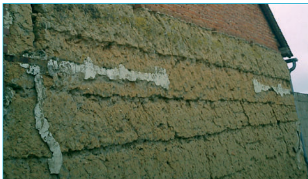
Mur en bauge. Broué.
