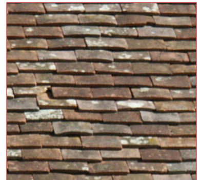
Tuiles de terre cuite, petit moule, rouge brun non uniforme.
