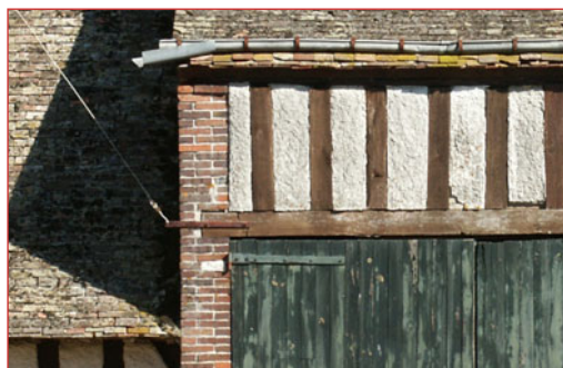
Colombages protégés par un lait de chaux.
