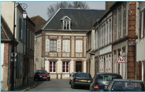
Maisons en maçonnerie de moellons enduite et brique appareillée. Brezollès.
