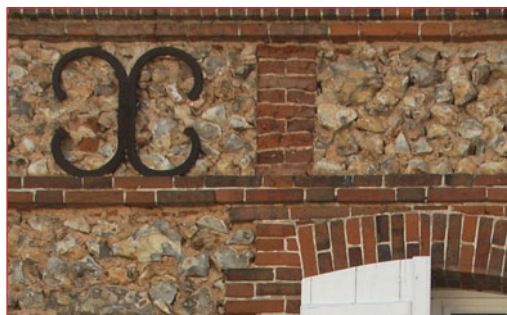
Maçonnerie de brique et silex.
