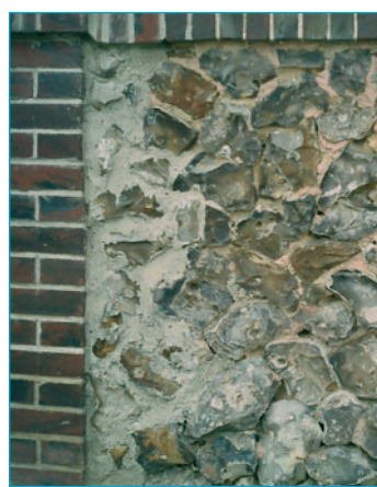
Mur en silex et chaîne en brique.
